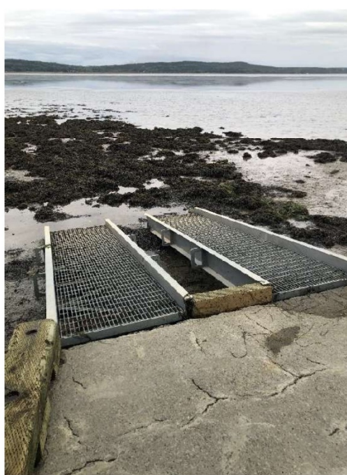
Prolongement de la rampe de mise à l'eau
