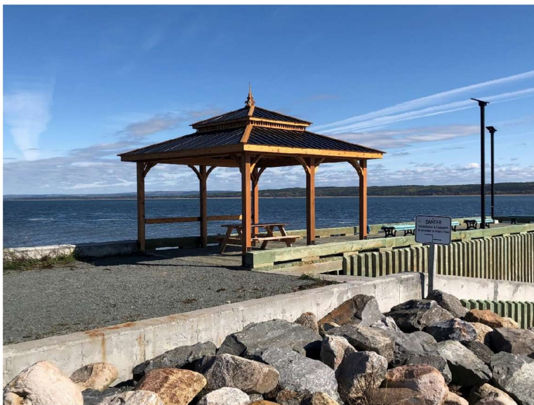
Installation d'un gazébo sur le quai
